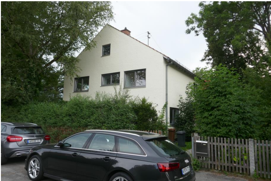
Abbildung 4: Eingang auf der Nordseite; von Kreuzeckstraße gesehen
